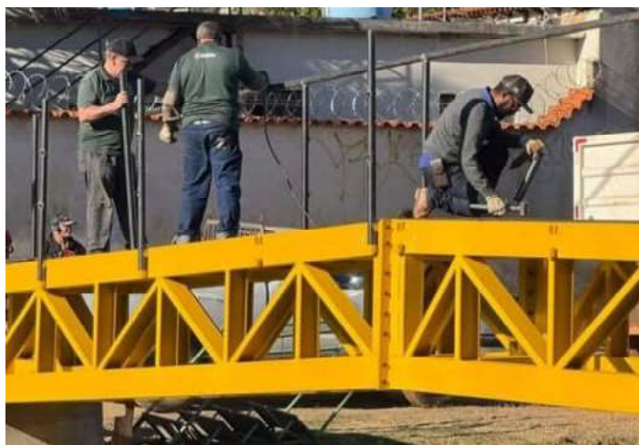
As obras de mobilidade urbana seguem avançando no município. Além do Várzea da
